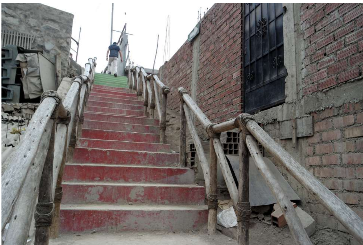
Figura 3. Escalera construida a través de dos proyectos de inversión pública confluyentes, uno promovido por la Municipalidad Metropolitana de Lima y el otro por la Municipalidad Distrital de Ate (2015).
